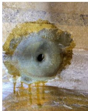
対応後：FRPで積層されたフランジ
