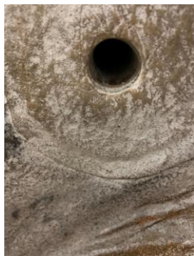
対応前：苛性ソーダの浸透が生じた小型フランジ
