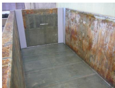
対応後：FRP特殊ライニング工法による恒久対応結果
