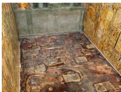
対応前：「つぎはぎ」のように補修された硝フッ酸槽
