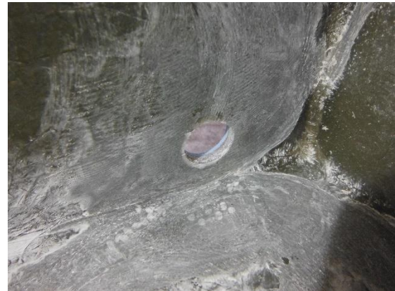
工程2: 解放面に対し、手作業による表面仕上げ実施
