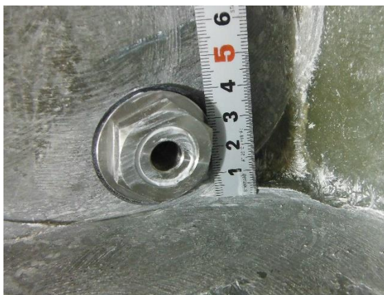
工程3: 吐水機構設置 (左下: 内面写真 右下: 外面写真)
